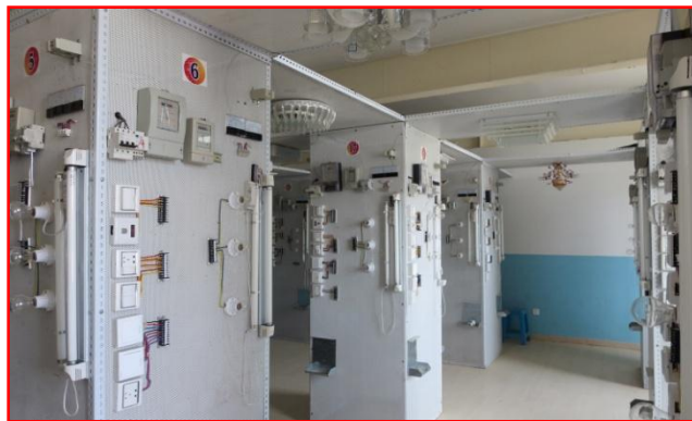
• 安装电工技术实训室
